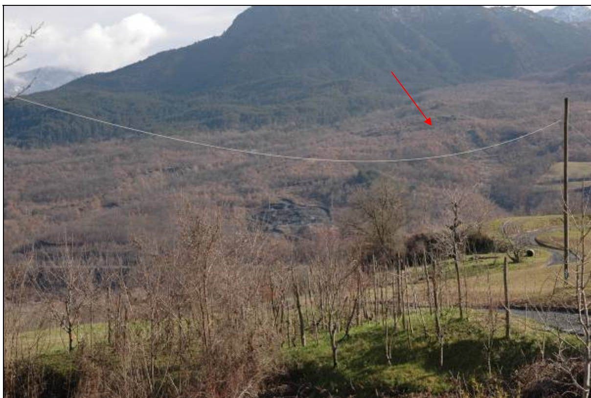
Figura 21 – Vista dell’ambito dal versante opposto presente in sinistra orografica rispetto al corso del Trebbia.
