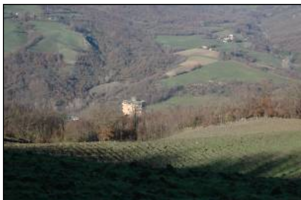
Figura 22 – (1) A nord, verso il fondo valle, è presente una struttura abitativa, disposta su 4-5 piani, in stato di abbandono
